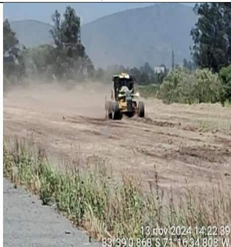
Roce mecanizado -km. 74+000
