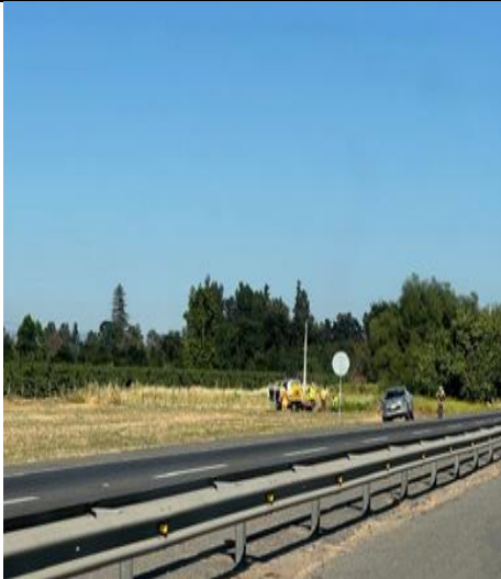
Limpieza y Mantenimiento de Faja Vial km. 64+000
