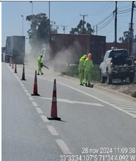
Mantenimiento de soleras Km. 104+300
