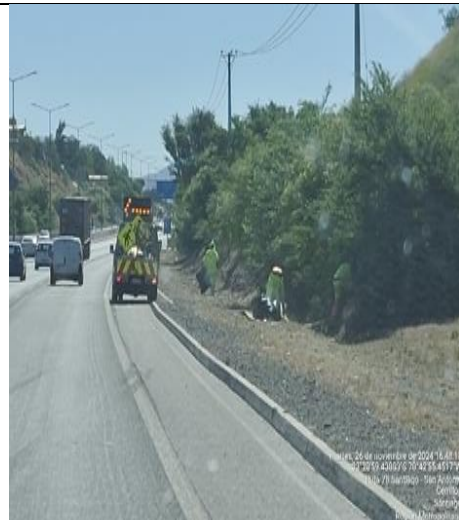
Limpieza y mantenimiento de faja km. 5+720-
