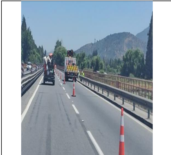
Reparación barrera de contención km.47+450-Asc.
