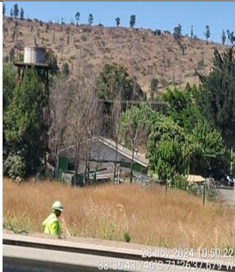
Limpieza de Fosos km. 90+900
