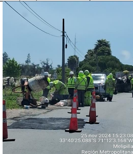
Sello de grietas CSD km. 66+010 Descendente
