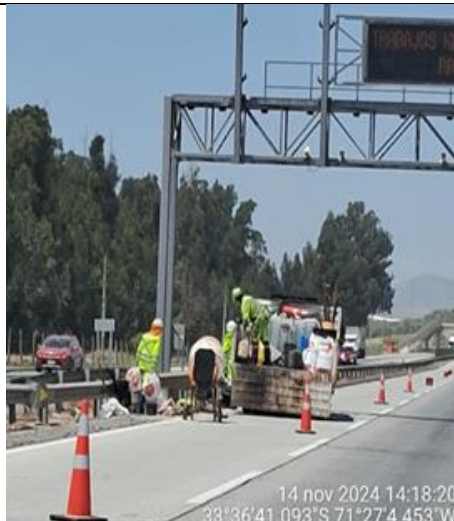
Mantenimiento de Bermas- km. 91+500
