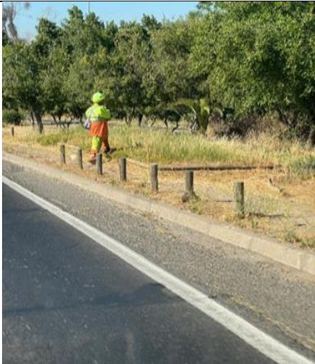
Limpieza y Mantenimiento de Faja Vial km. 64+000
