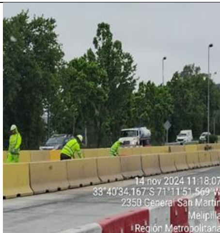
Demolición peajes Melipilla 2-3 km.65+700 -Mediana
