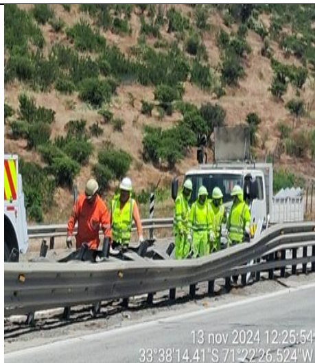
Reposición Defensas Triple onda km. 87+750 Mediana
