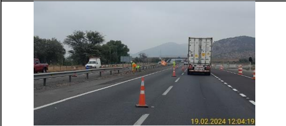
Reposiciones barreras metálicas- Km 54,300
