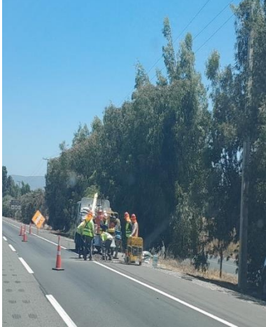
Bache en berma Km 42,000 Asc
