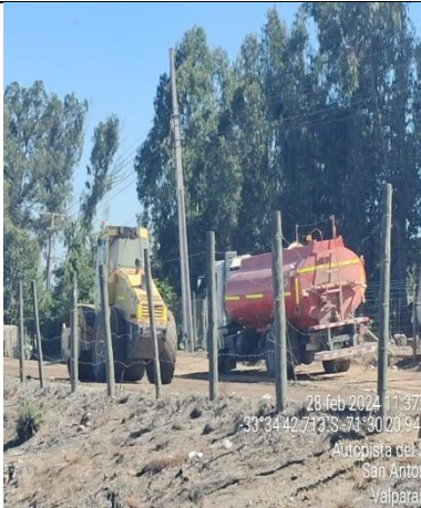
Mantenimiento calles de servicio Norte Km 98,000
