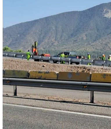
Instalación defensas – Km 54,720, Chiñigüe, Desc
