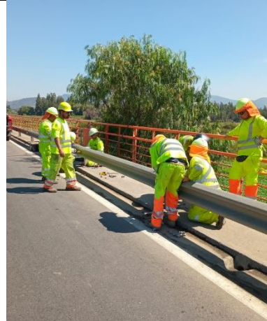
Reparación defensas Pte Manuel Rodriguez
