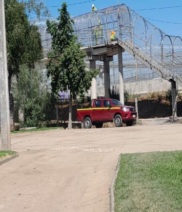
Reparación mallas antivandálicas- Rinconada
