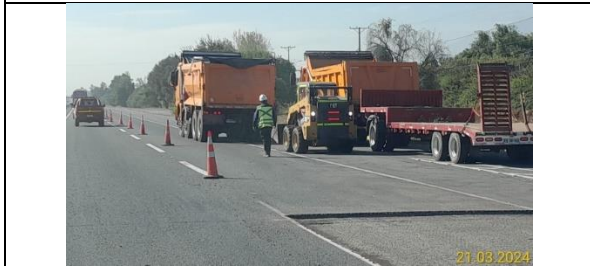
Bacheo calzada izquierda – km 56,000
