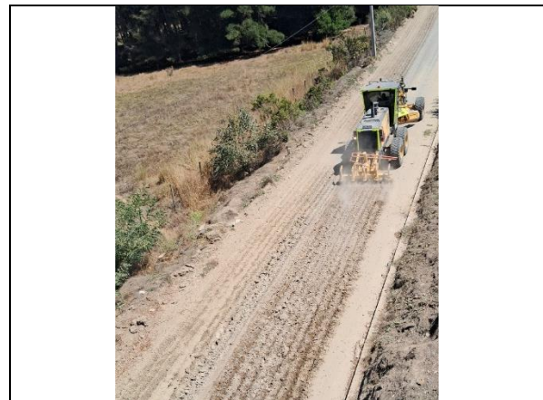
Mantenimiento calles de servicio - km.95,400- Desc.
