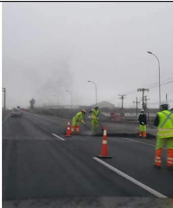
Limpieza barricadas NAPSA – km 6,000 Desc
