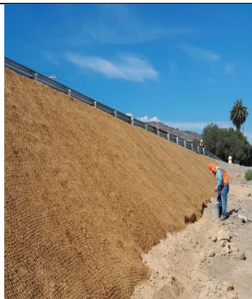
Instalación geomanta COAVECS - Chiñigüe
