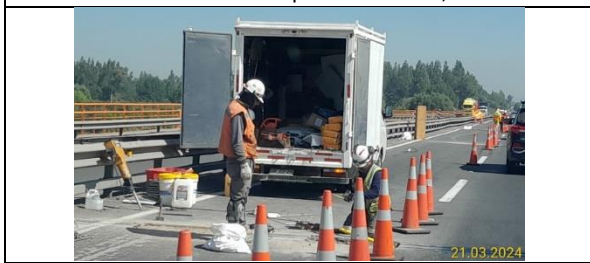
Juntas de dilatación- Km 47,500 Der.
