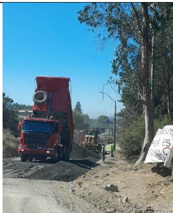
Aplicación RAP CS Sur - Km 95,400
