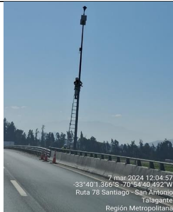
Mantenimiento luminaria – km 37,180
