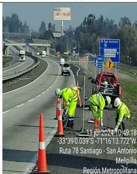
Bacheo en frío- berma- km. 73+500 -Ascendente
