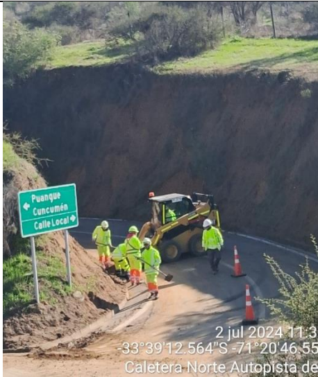
Limpieza de cunetas- km. 80+500
