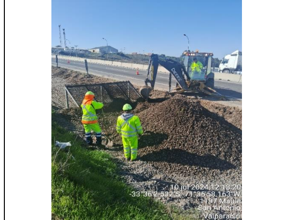
Mantenimiento de Pista de Emergencia- km.5+700- NAPSA
