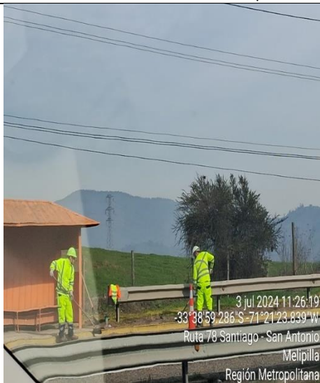
Limpieza de cunetas- km. 81+600
