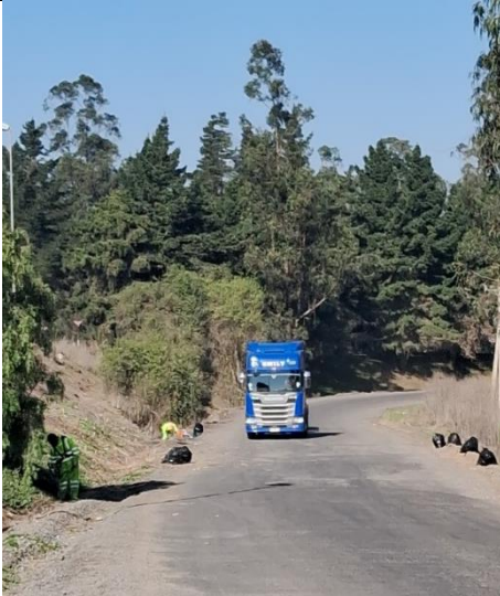
Limpeza de faja- CS Sur-km. 101+100
