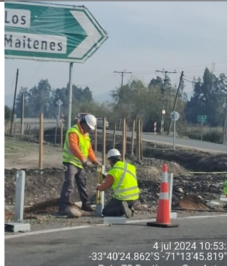
Reparación de Defensas-km. 68+730 -ascendente
