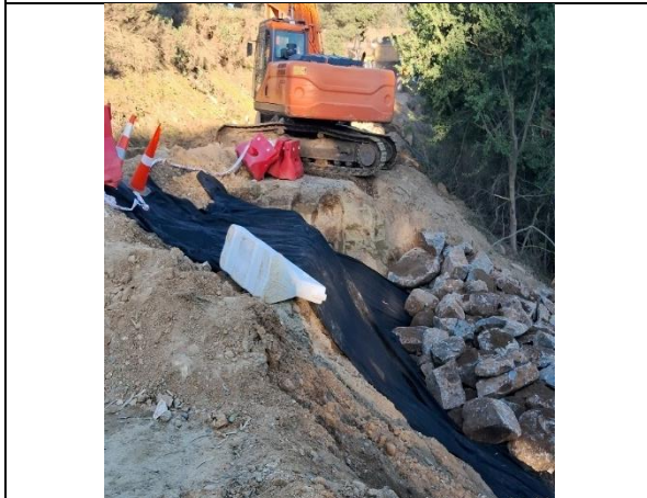
Trabajos de enrocado por socavón- km- 97+300 CS Sur
