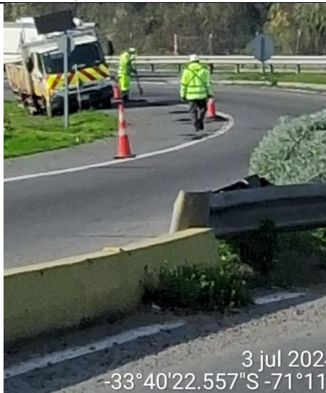
Bacheo en berma Ramal E. Melipilla
