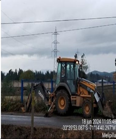
Limpieza de Fosos km. 70+500- CS Norte
