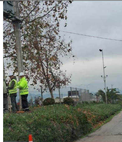
Mantenimiento sistema eléctrico km. 65+700
