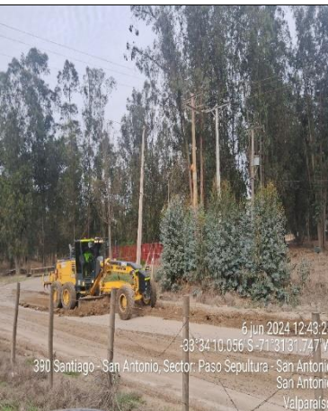
Reparación superficial de pavimentos en Calle de Servicio Sur- km. 100+300
