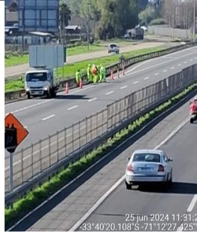
Bacheo en frío km. 66+500
