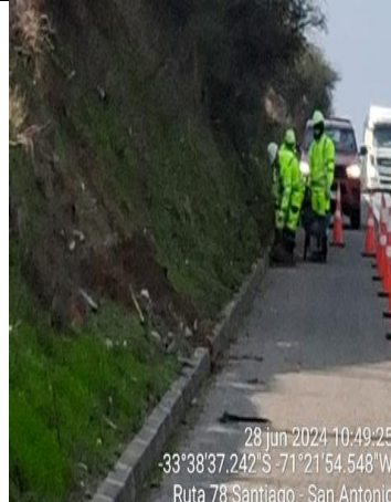
Limpieza de Soleras km. 82+600 -Asc.
