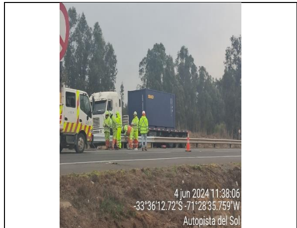
Reparación de defensas km. 94+200- Mediana
