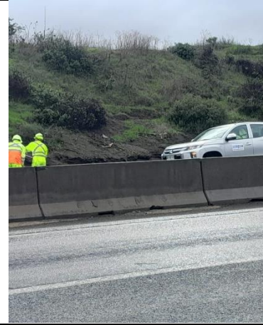
Limpieza de Cunetas NAPSA-km. 6+150
