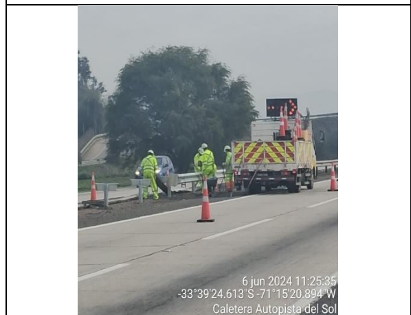
Reparación de defensas - km. 71+900 Mediana
