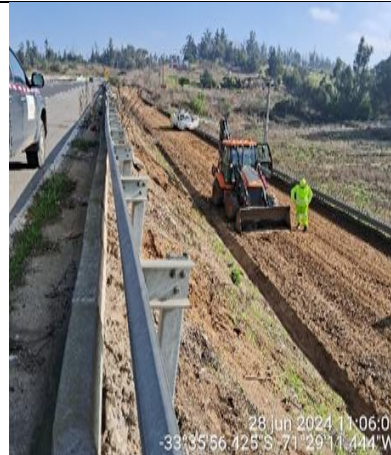
Mantenimiento de Calle de Servicio km. 95+200
