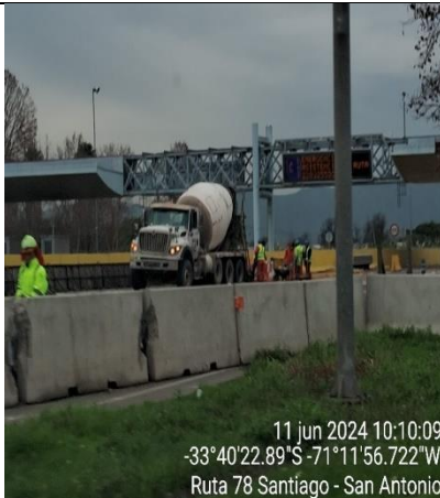
Construcción de defensas in situ- ex Peaje Troncal Melipilla I
