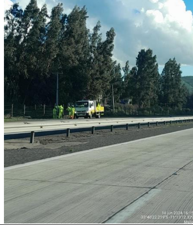
Reposición de Señal vertical km. 67+800- Desc
