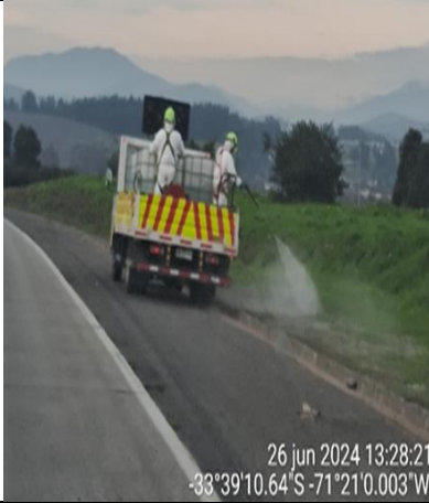
Aplicación de herbicida km. 80+900
