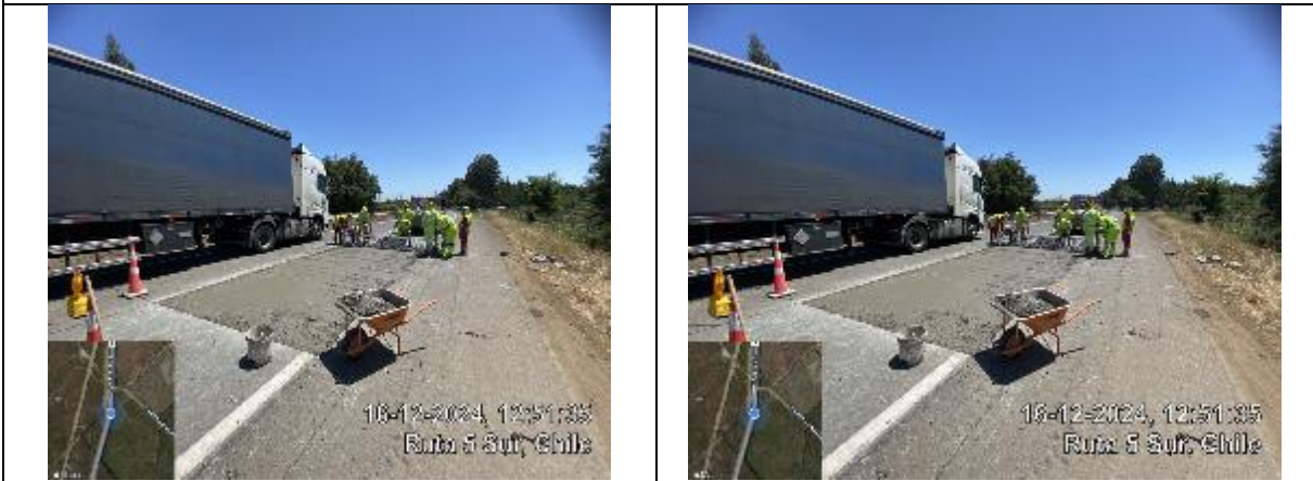
Inspección Tramos de Losas de Hormigón
