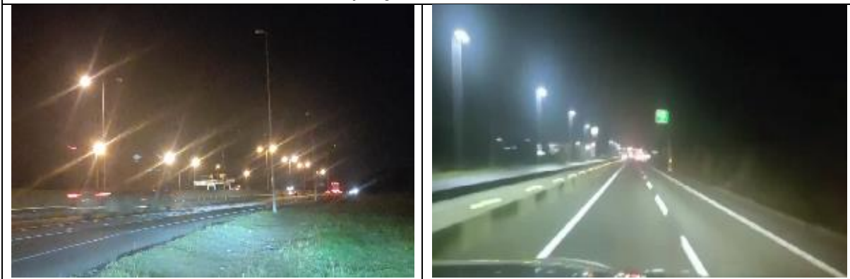
Inspección de Luminarias
