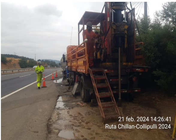
Trabajos de sondajes, sector Collipulli.
