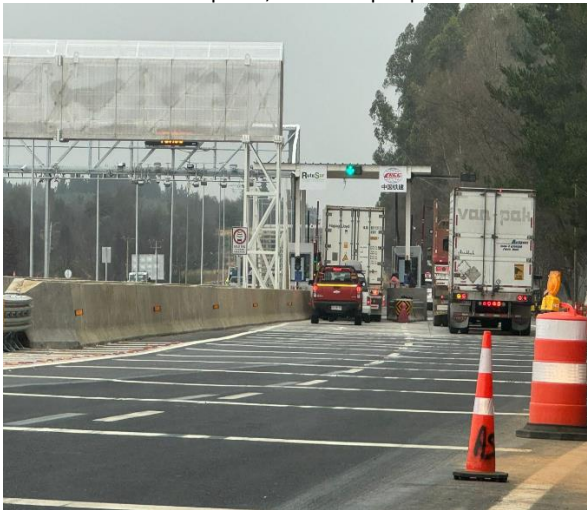
Instalación parte superior pasarela, Plaza de peaje Las Maicas.
