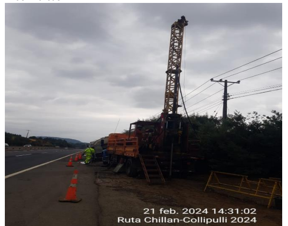
Trabajos de sondajes, sector Collipulli.
