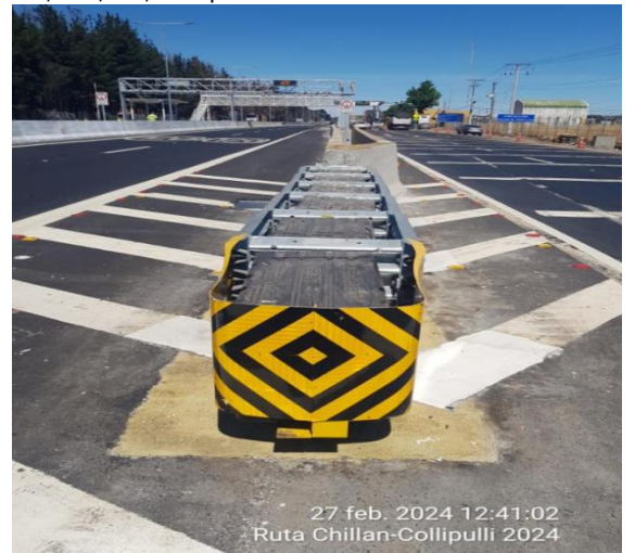
Instalación amortiguador de impacto, Plaza de peaje Las Maicas.
