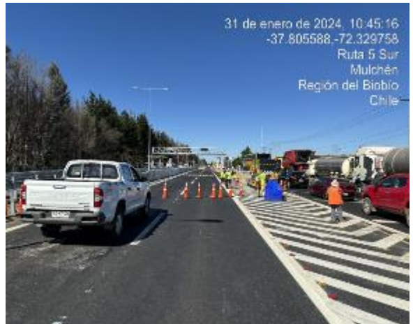
Trabajos de demarcación, Plaza de peaje Santa Clara.
