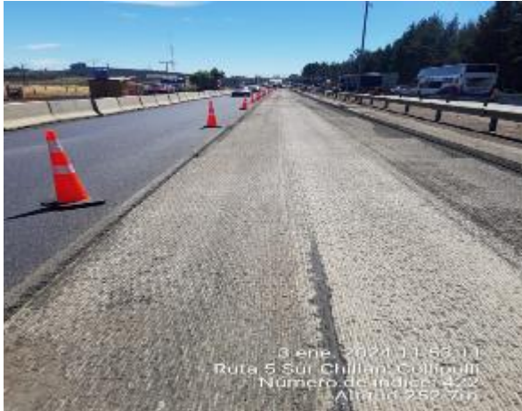
Continuación trabajos de asfalto, Plaza de peaje Las Maicas.
