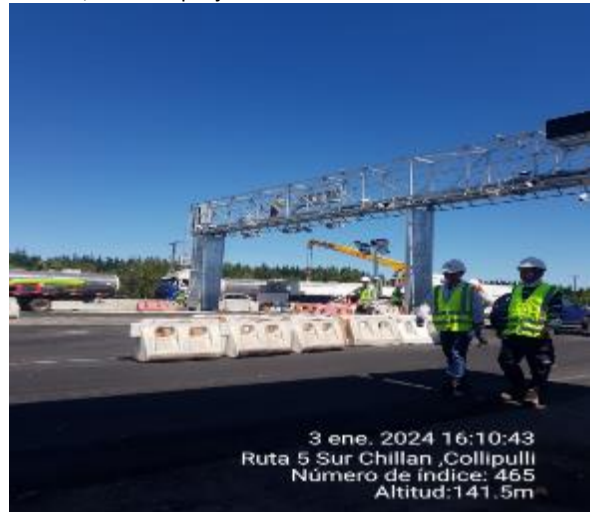
Trabajos en Pórtico Fee Flow, Plazo de peaje Santa Clara
