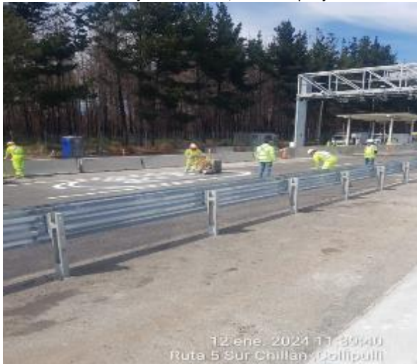
Instalación barreras metálicas y demarcación, Plaza de peaje Las Maicas.
