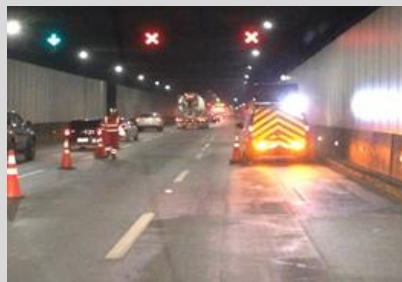
Personal en la vía con EPP adecuados
