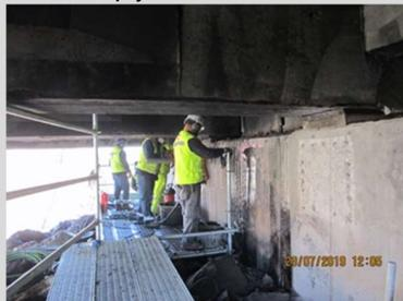
En SOP. Eje Costanera Norte, en túnel bajo río Norte, se registran trabajos de reparación de filtraciones en muros lado norte, km. 16,910; 16,920; 16,940.-
