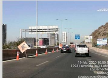
Se observa segregación de pista izquierda por trabajos programados por faenas de fundación para pórtico.
