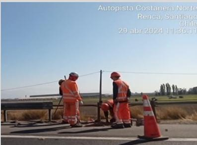
SOP. Eje Kennedy. Km 6.100, Reemplazo Puerta de Salida Peatonal de Emergencia con marco dañado.
