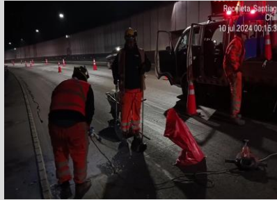
SOP. Km 15.200. Mediana. Reemplazo defensa de hormigón.
