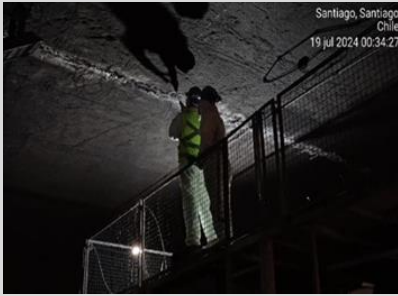
SOP, Eje CN, sentido P-O; Km. 17,500; Inyección losa superior de Paso Inferior.
