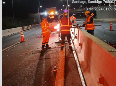
Km. 2.620 mediana reparación y cambio de luminarias
