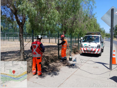
Km. 25,700; Reparación reja perímetro Parque Renca
