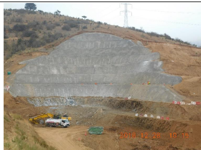
Vista panorámica Portal Norte
