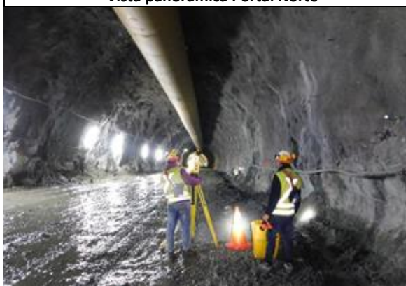
Control Topográfico al Túnel Norte
