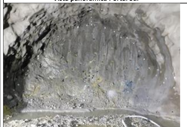
Perforación de frente carga interior del Túnel Sur
