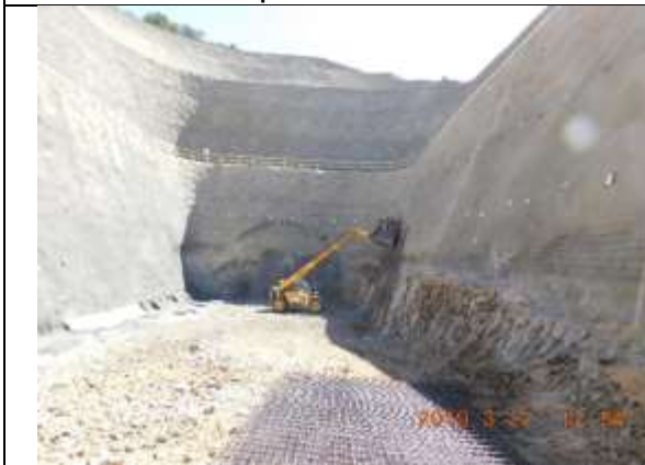
Banco 5B colocación malla electrosoldada, lado Oriente
