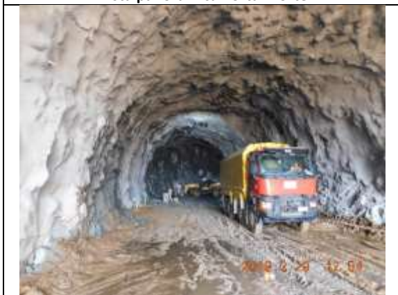
Vista interior nuevo Túnel Acceso Norte
