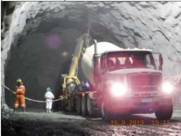
**Colocación última capa shotcrete en interior Túnel Norte**
