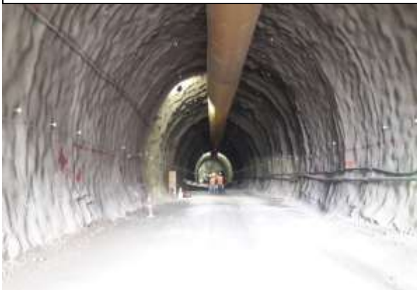
Vista interior Túnel Sur
