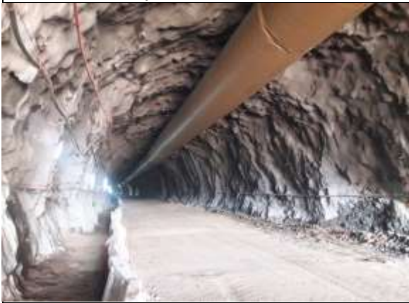
Vista interior Túnel Norte
