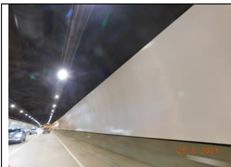
Túnel II, revestimiento e iluminación
