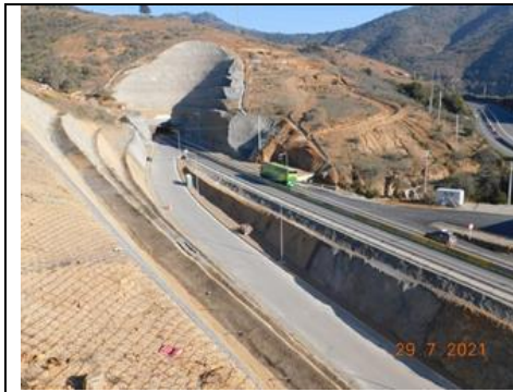
Vista panorámica Portal Norte
