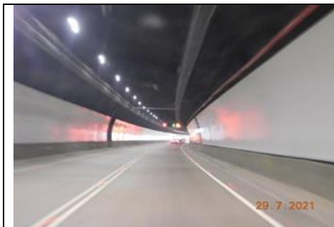
Túnel II con tránsito y equipos funcionando
