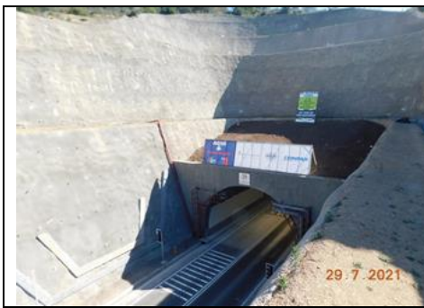
Banquetas y Boca Entrada Túnel Falso Sur
