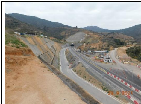
Vista panorámica Portal Norte
