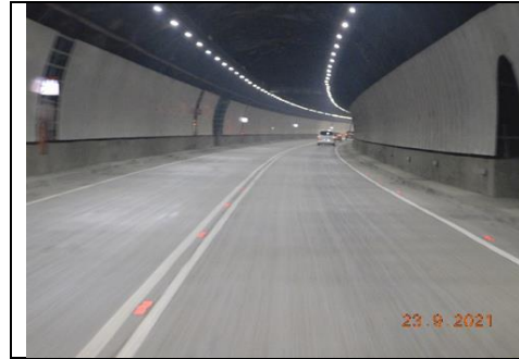
Túnel II, revestimiento e iluminación
