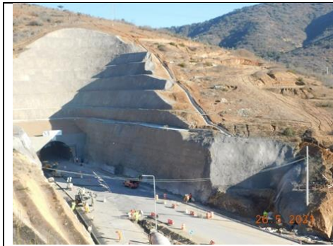
Vista panorámica Portal Norte
