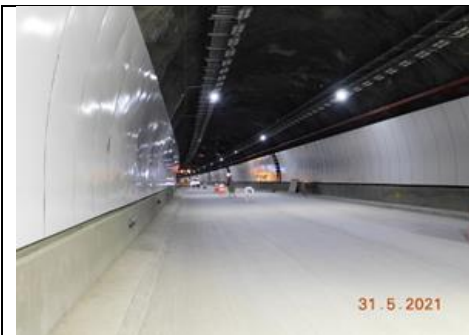
Instalación revestimiento de acero vitrificado
