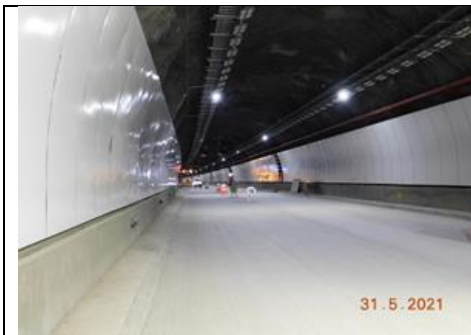
Instalación revestimiento de acero vitrificado
