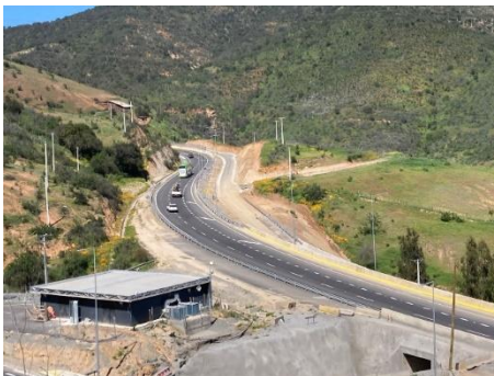
Plataforma eje 2, lado poniente, acceso a túnel 1
