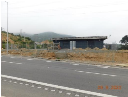
Vista estructura CT-4
