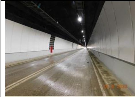
Túnel I con paneles vitrificados instalados y limpieza de pavimento.
