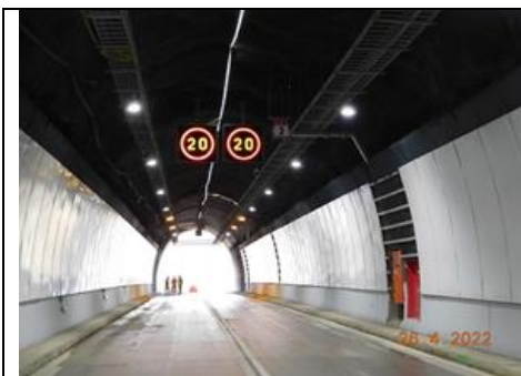
Instalación señales velocidad máxima Túnel I
