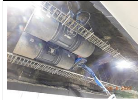
Instalación ventiladores, Túnel I
