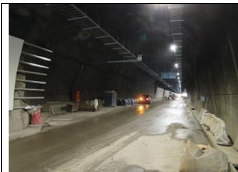
Bahía de detención túnel I
