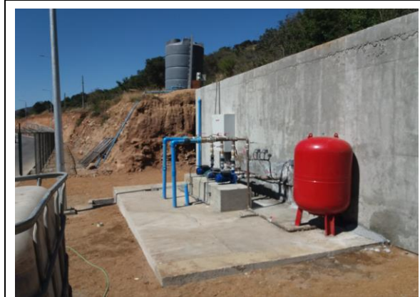
Estanque de agua, ESCC (frente sur)
