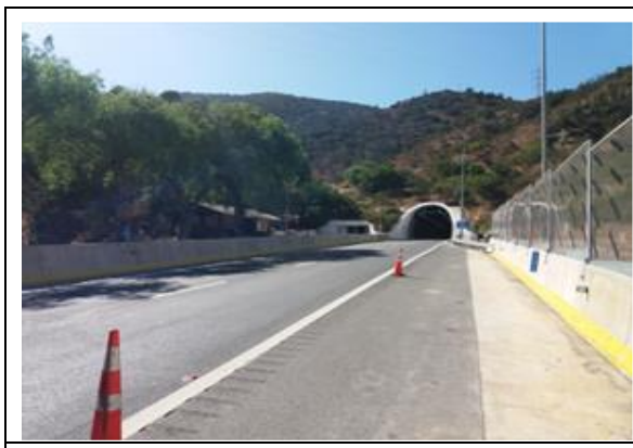
Entrada Túnel T1 (acceso norte)
