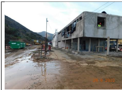
Ampliación edificio de control, frente sur
