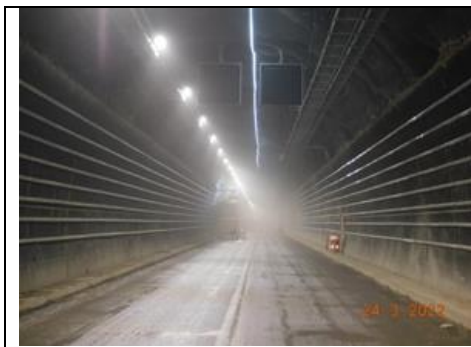
Instalación de montantes, Túnel I
