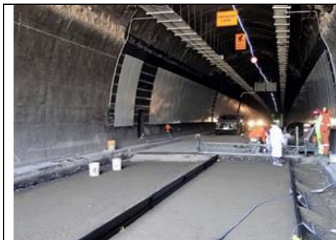
Hormigonado pavimento salida Túnel I
