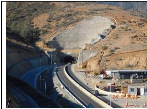
Pavimento Calzada Eje 1 y 4, Portal Norte
