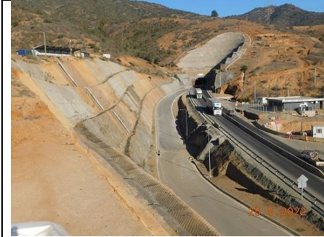
Talud de corte para Eje 4, frente norte
