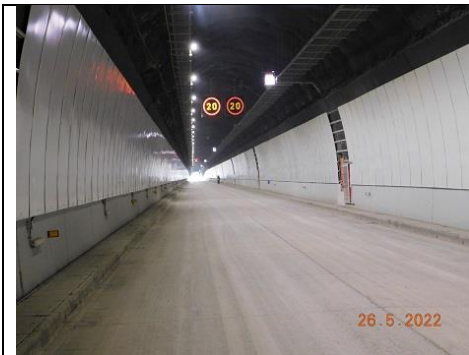
Instalación de montantes, Túnel 1
