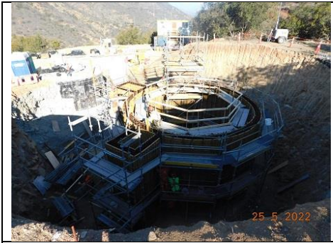
Estanque Red de Incendio, frente sur
