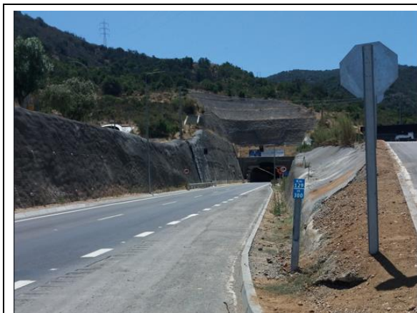
Estación meteorológica en entrada Túnel 2
