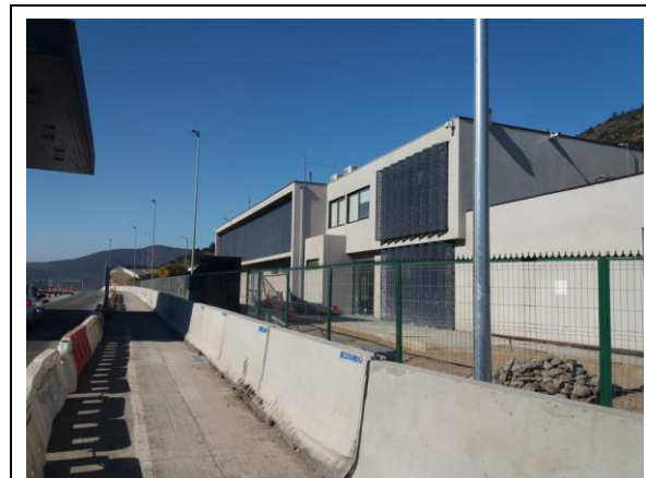
Edificio SCC, frente sur
