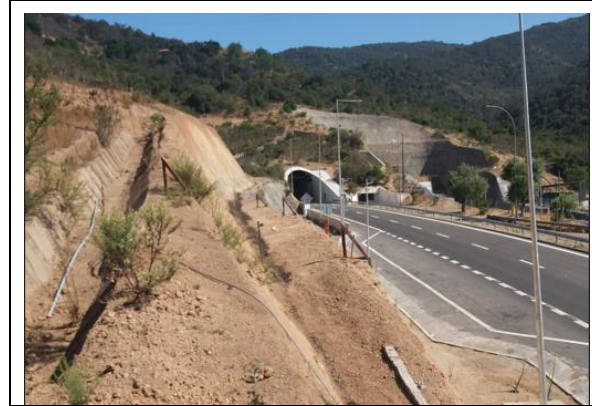
Salida Túnel 1 (acceso sur)
