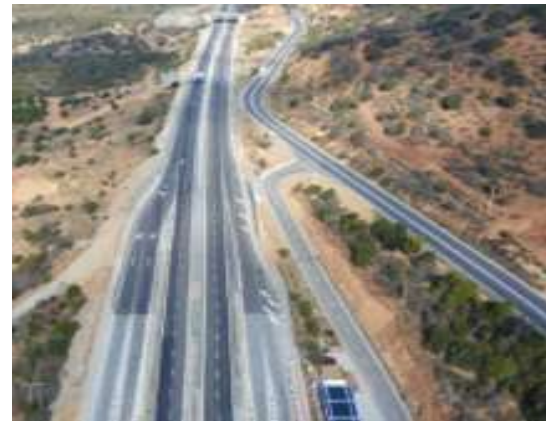
Acceso Sur Sector Peaje; Eje 1 de Sur a Norte, Eje 2 de Norte a Sur y Ruta E-47 Cuesta El Melón
