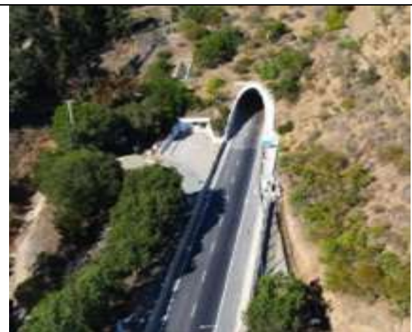
Brocal Norte de Eje 2 al Sur
