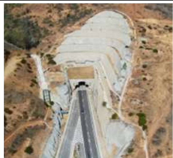
Brocal Norte Eje 1 de Sur a Norte
