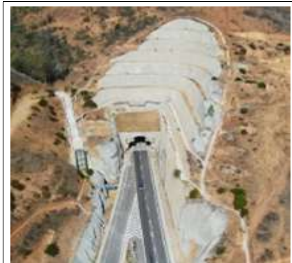
Brocal Norte Eje 1 de Sur a Norte
