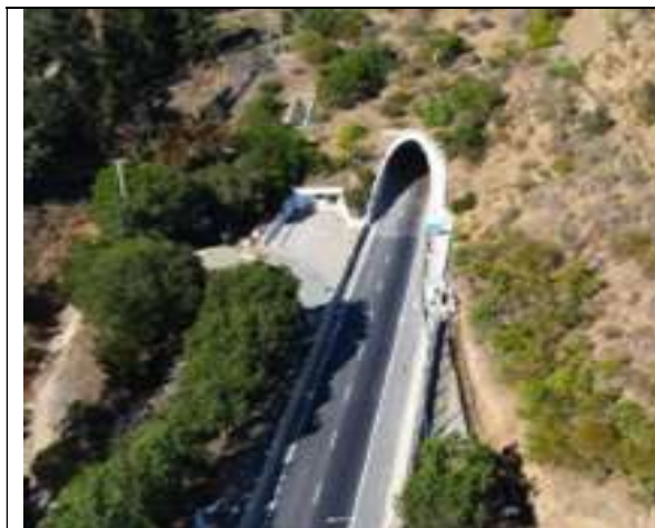
Brocal Norte de Eje 2 al Sur
