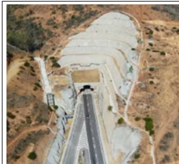
Brocal Norte Eje 1 de Sur a Norte
