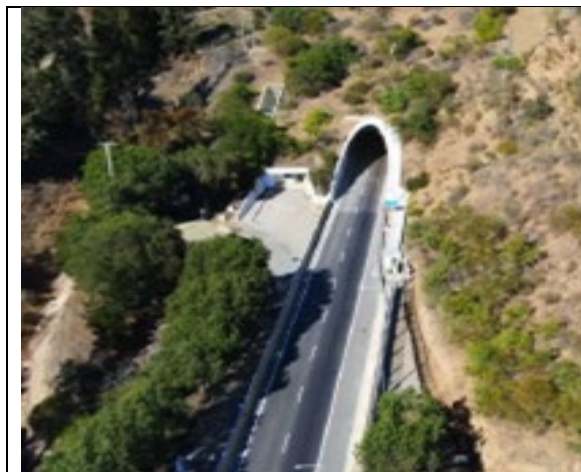
Brocal Norte de Eje 2 al Sur
