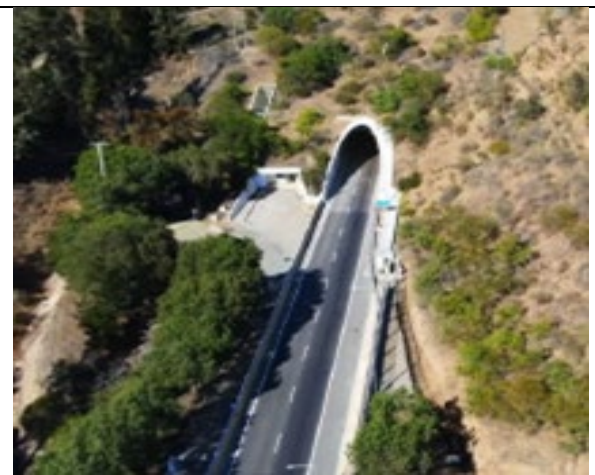
Brocal Norte de Eje 2 al Sur
