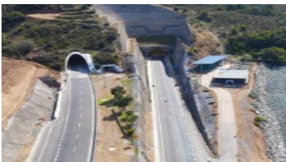
Brocal Sur de Eje 2 al Sur y Eje 1 al Norte
