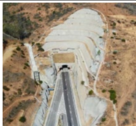
Brocal Norte Eje 1 de Sur a Norte
