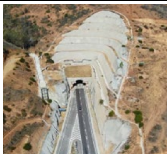
Brocal Norte Eje 1 de Sur a Norte
