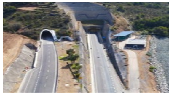
Brocal Sur de Eje 2 al Sur y Eje 1 al Norte
