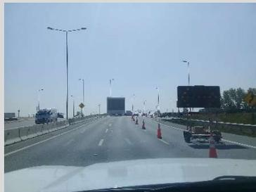
En AMB, km. 0,900 calzada oriente; se verifica la ejecución de trabajos de limpieza de reflectantes laterales.
