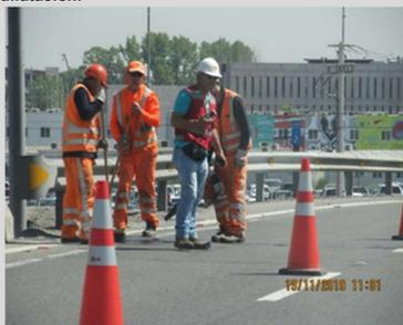
En AMB, Km. 0,000 calzada oriente; se verifica ejecución de trabajos de limpieza en cunetas revestidas.
