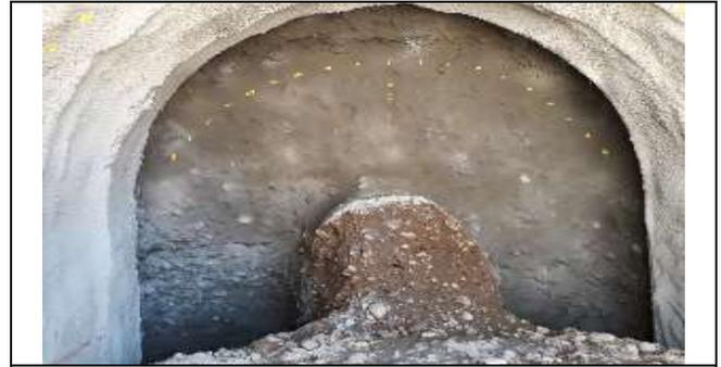
Infiltración Caja Izquierda Túnel N-S
