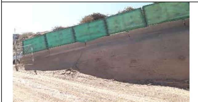
Fisuras en shotcrete de Talud Acopio lado Portal Norte
