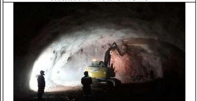
Frente Túnel AVO N-S con ST Tipo III perfilado con martillo
