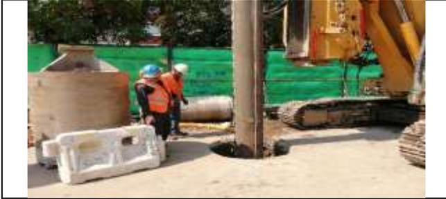
Sector 2: Nudo Apoquindo Excavación Pilotera (Pilote 13)
