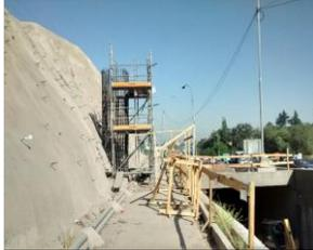
**(05.12.2019), Viaducto El Salto, Cepa N° 8**, excavación manual de Pilotes N° 2 y 4 de Cepa; Las excavaciones de Pilotes N° 1 y 3.
