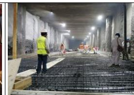
**Trinchera Cubierta Sector 1, Losa Intermedia N° 28**, colocación de hormigón de Losa, 223 m3 **(11.12.2019)**.
