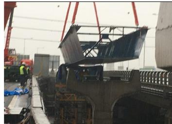
(04.07.2020), Viga 4. Operación de izaje de viga para montaje sobre cepas 3 y 3.
