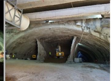
Túnel Híbrido frente norte se ejecuta con 3 fases secuenciadas. Zona de transición de trinchera cubierta a túnel híbrido.
