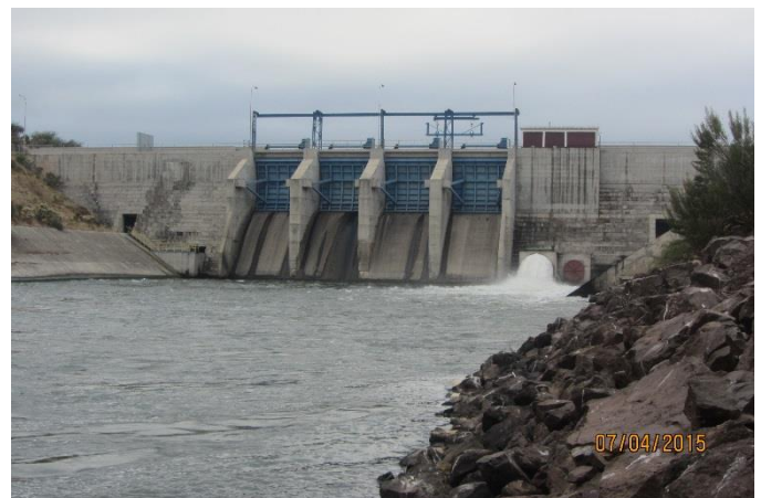
Presas Auxiliar, aguas abajo
