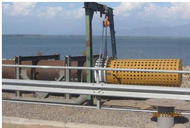
Spool N° 1, con patín de apoyo en el fondo, Válvula Dúo Check (de retención) y filtro de la aducción del Sifón Santa Adela.
