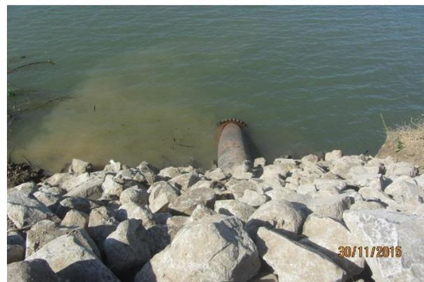
Término relleno de Zanja y Enrocado talud aguas arriba Sifón Santa Adela. Se aprecia el inicio del Spool N° 4.
