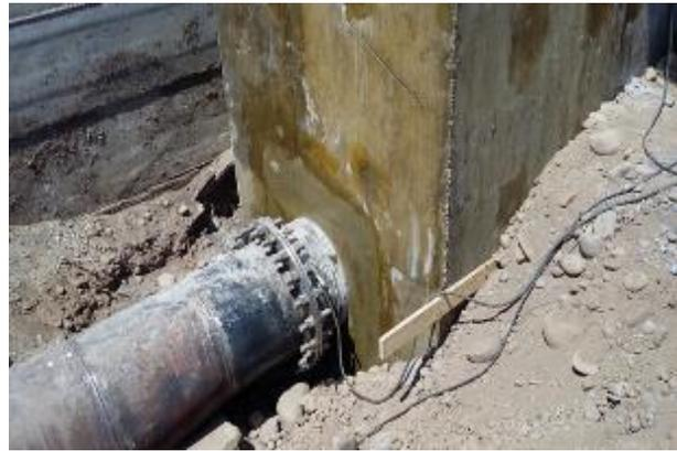
Hormigonado de la Cámara de Válvulas y del Carrete que sostiene la Válvula de Mariposa en su interior. Este trabajo se realizó en dos etapas: Hormigón Cámara de Válvulas dejando las pasadas para los Carretes (2). Una vez alineado tanto los carretes como la válvula, se hormigonó la 2ª etapa. 23 de diciembre de 2015.
