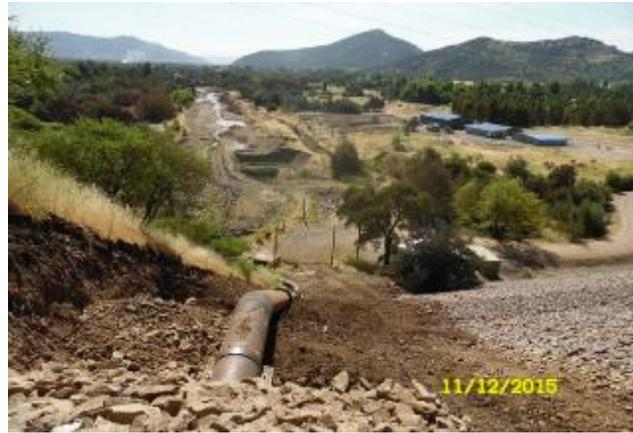
Imagen panorámica desde el lado Sur del Muro. Primer plano el Sifón Santa Adela, luego las excavaciones de la Casa de Máquinas y la limpieza del Canal de Restitución. Al lado derecho, la Instalación de Faenas.
