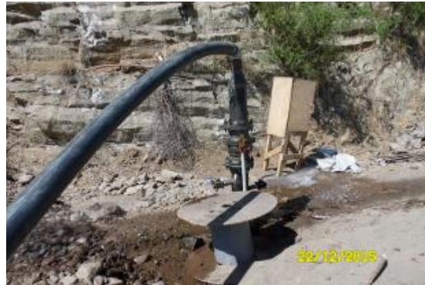
Llenado del Sifón Santa Adela para comprobar su estanqueidad, mediante el Spool N° 8 con sus tres válvulas. El Sifón permanecerá lleno hasta las instalaciones de los Spools N° 1, 2 y 3, que van sumergidos con su válvula Check y Filtro.
