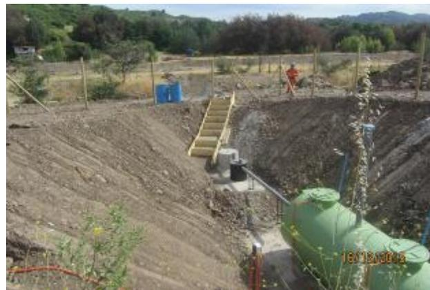
Instalación de Cerco Perimetral y Escalera de la Planta de Tratamiento de Aguas Servidas. Baños funcionando.
