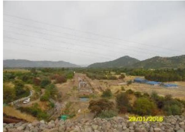
A la izquierda, el Canal Santa Adela y parte del Sifón Santa Adela, luego el Canal de Descarga del Túnel Sur y las excavaciones de la Casa de Máquinas, finalmente el Canal de Restitución y la Instalación de Faenas. Se aprecia línea de alta tensión de 154 kV.
