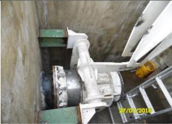
Cámara de Válvulas del Sifón Santa Adela. Mecanismos de accionamiento de la Válvula Howell Bunger
