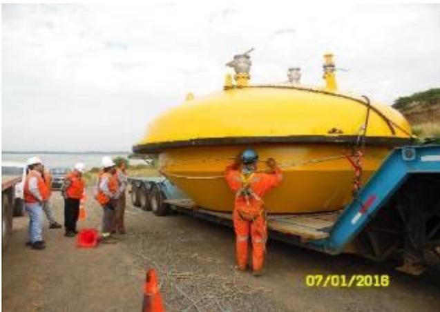
Llegada del Tapón Toriesférico al Muelle ubicado aguas arriba de la Presa Auxiliar. Se distinguen sus tres válvulas
