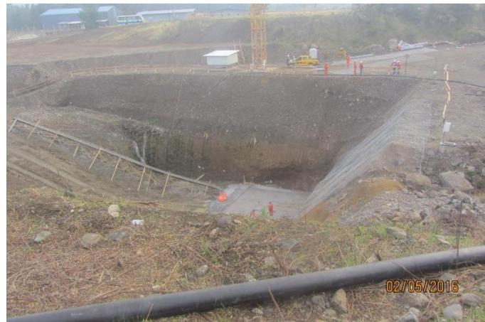
Vista panorámica de la Excavación y Fundación de la Casa de Máquinas. Se aprecia la canoa para hormigonar, la malla tipo biscocho para los taludes y la camioneta de la empresa Vitta Mac con el personal para calibrar la Grúa Torre marca Zoom Lion Mod. TC 5013 B, de 1,3 Ton. a 50 metros..
