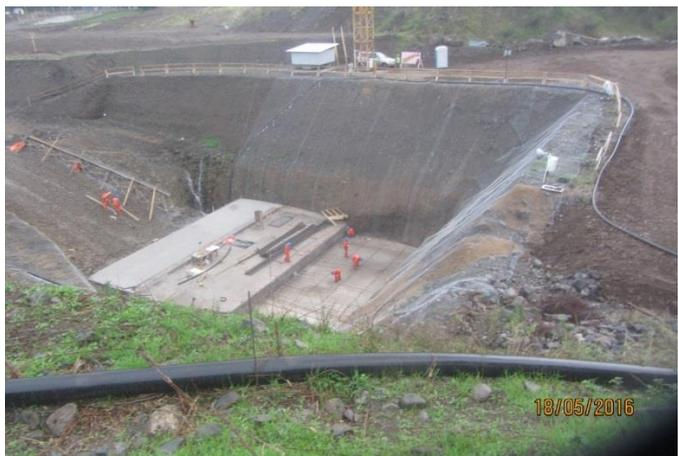
Término del Hormigonado de la 1ª etapa del Canal de Descarga e inicio de la Colocación de Fierro sobre el Radier
