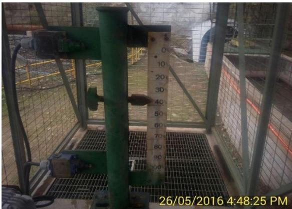
Para evacuar, por arrastre, el aire acumulado en la parte alta del Sifón Santa Adela (Spool N° 9), se abre la válvula Howell Bunger ubicada en la Cámara de Válvulas, a un 40% aproximadamente. Esta apertura de la válvula a un 40% app., equivale a un caudal aproximado de unos 1.000 lts/seg. Con la apertura normal, de un 7%, de la válvula Howell Bunger, el caudal es de unos 150 a 200 lts/seg.
