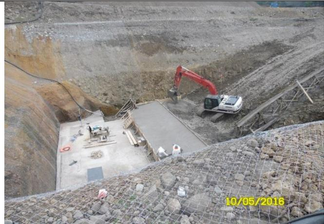
Término de la 2ª etapa y Hormigonado, con H10 y Bolón Desplazador, de la 3ª etapa del radier con el apoyo de la Excavadora Link Belt 210. El trabajo se realiza en 2 etapas.
