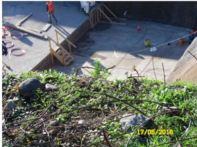
Soldadura de las uniones de la Malla de Tierra, con cable desnudo 4/0 AWG, sobre el radier de la Casa de Máquinas.
