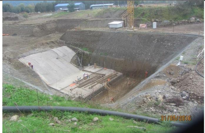
Enfierradura de la Fundación de la Casa de Máquinas, 2° hormigones de la Fundación, Radier y emplantillado de la 1ª y 2ª etapa del Canal de Descarga y excavación del Diente Norte del Canal de Descarga de la Central.
