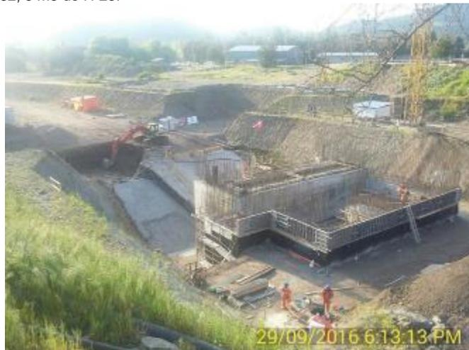
Emplantillado Fundación Muro Modificado del Canal de Descarga. 14 m<sup>3</sup> de H-10. 7ª Etapa de Hormigonado. Se aprecia el relleno de la cuña del lado Oriente de la Casa de Máquinas.
