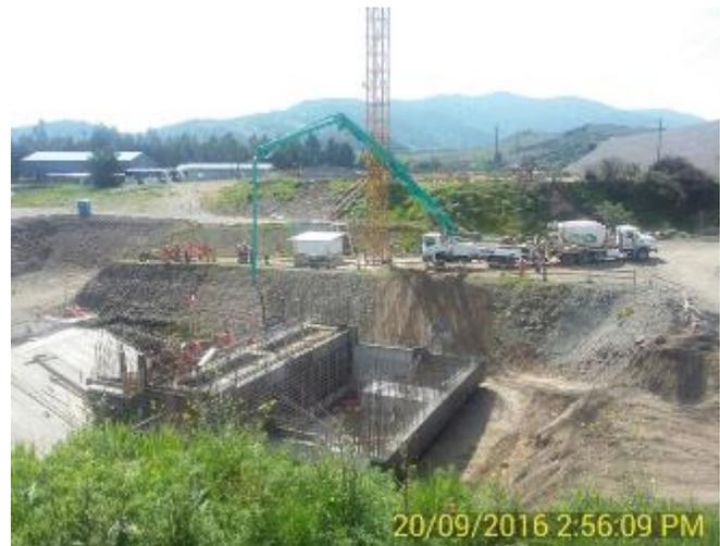
Hormigones muros N° 12, 16, 19 y 20 de la 4ª Etapa de Hormigonado. 82, 5 m<sup>3</sup> de H-25.
