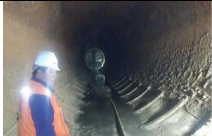
Tubería de 6.500 mm de diámetro, donde se aprecian las vigas T de refuerzo. En primer plano se ve al señor René Valenzuela, Jefe de Obra de la CHCV, y al fondo la Compuerta de Segmentos armada por los Buzos de Trasubmar, a 35 m de profundidad.
