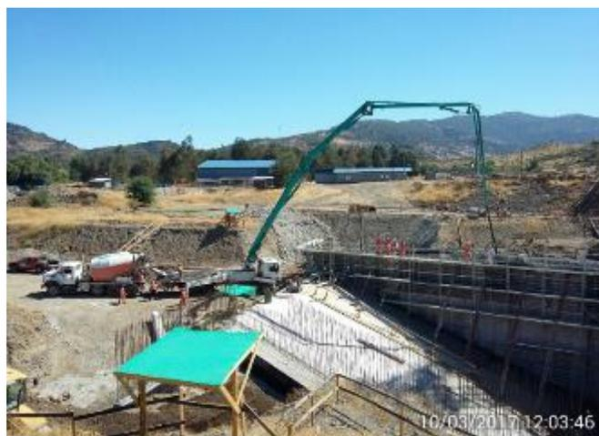
Hormigonado del muro del lado norte, del último tramo del Canal de Descarga (3°) y del muro del lado norte del Diente. Son 70 m<sup>3</sup> de H30.
