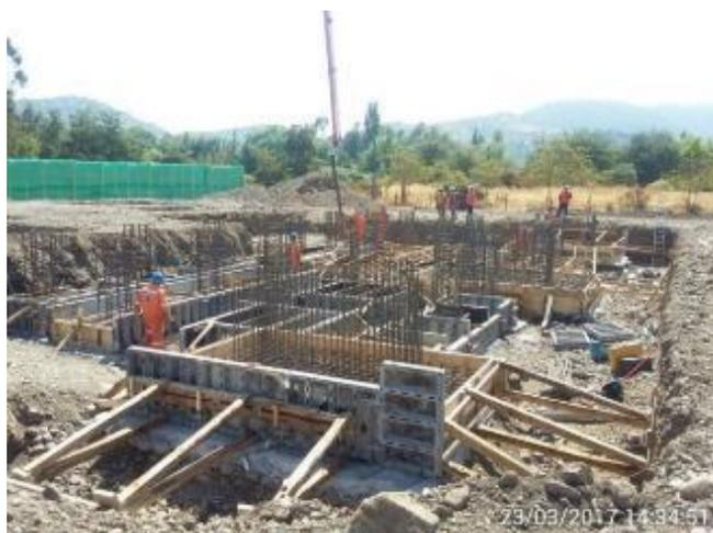
Recepción de la enfierradura y el moldaje de las Fundaciones F1 a la F6 de la S/E de la Central.
