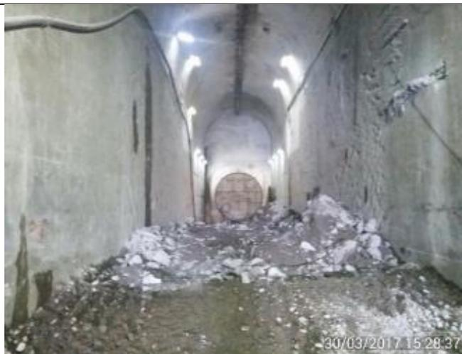
Demolición final de la Cámara de Válvulas del Túnel Sur. Se aprecia la Tapa de Seguridad de la Tubería de 3.800 mm.
