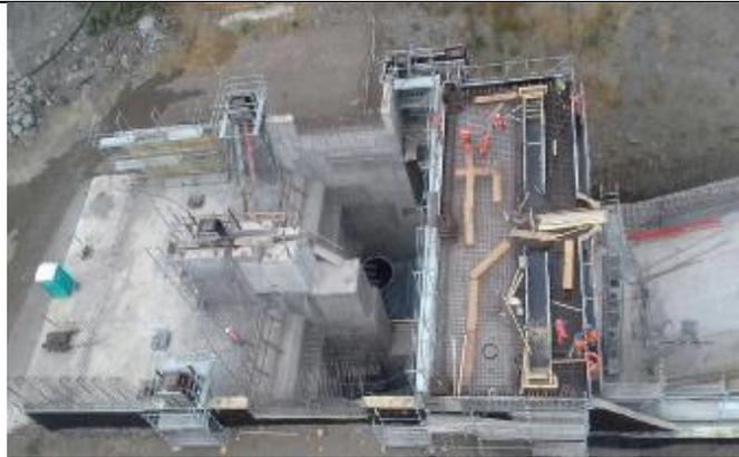
Vista aérea de la Casa de Máquinas de la Central en construcción y de la losa a cota 243,700, entre muros 29 y 30 y zona compuertas. Se aprecian parte del Difusor U1 (lado norte) y U2 (lado sur), instalados.
